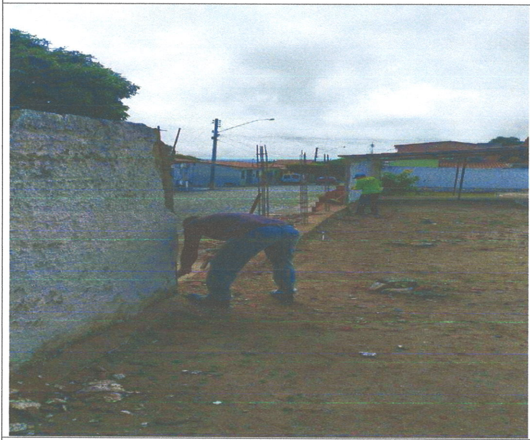
Reconstrução do muro
