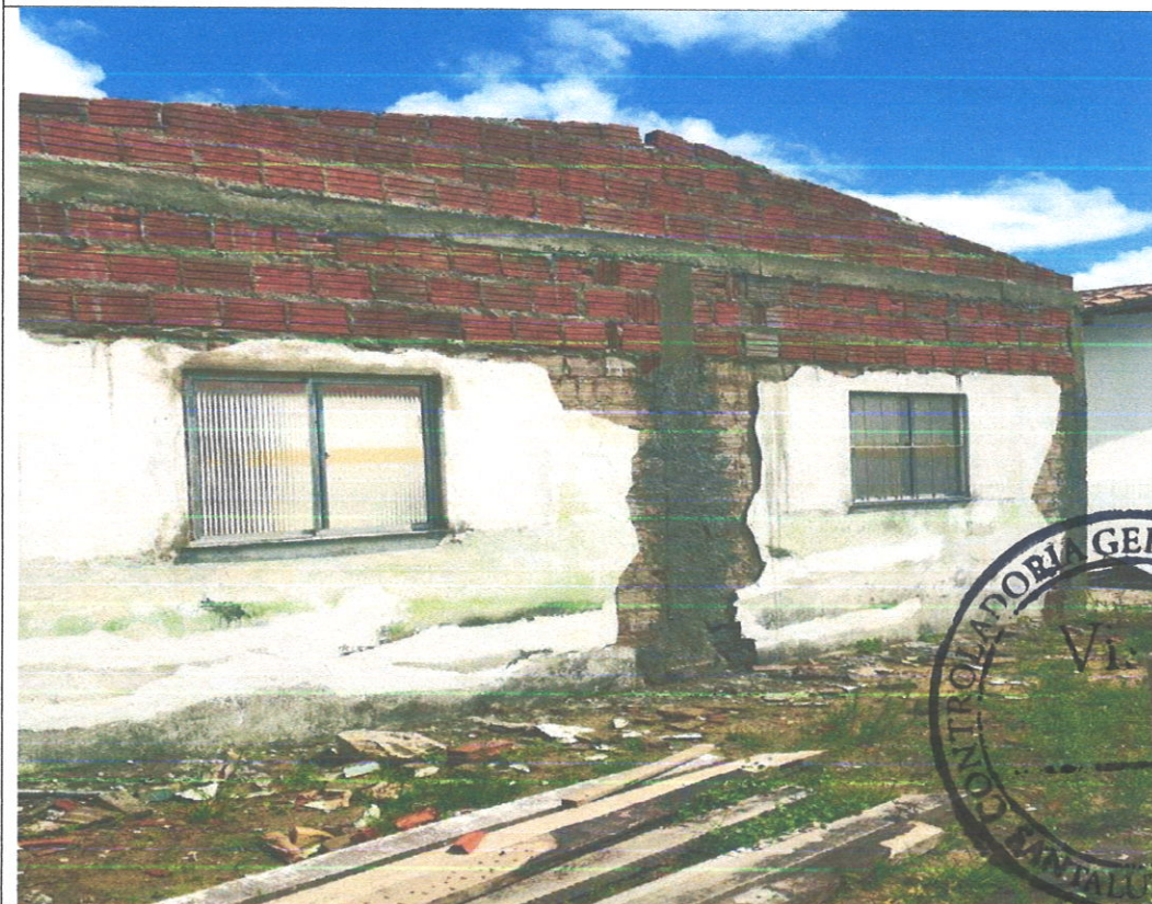
Aumento de pé direito e reconstrução da estrutura das salas.
